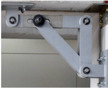
图7 三角形滑动摩擦梁柱节点 [31]
